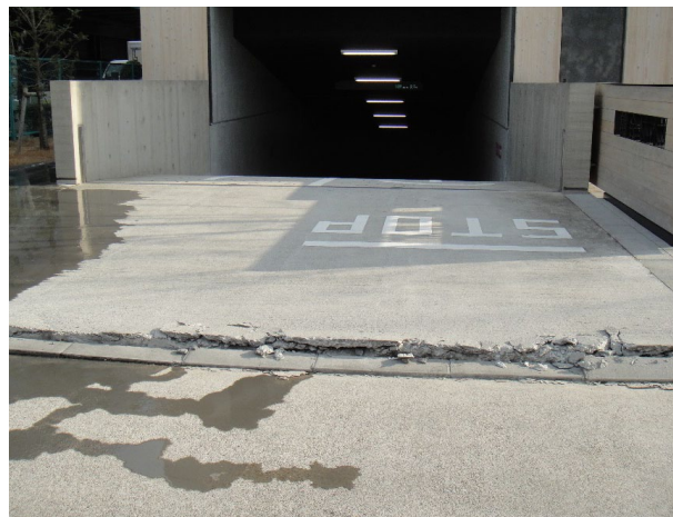
木材会館・地下駐車場スロープ前。 段差が生じました。
