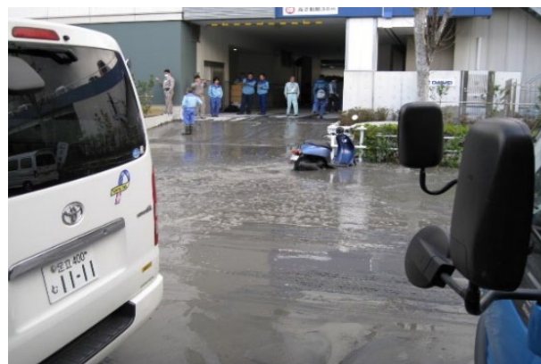
道路は液状化現象により、噴砂が発生 新木場2丁目
