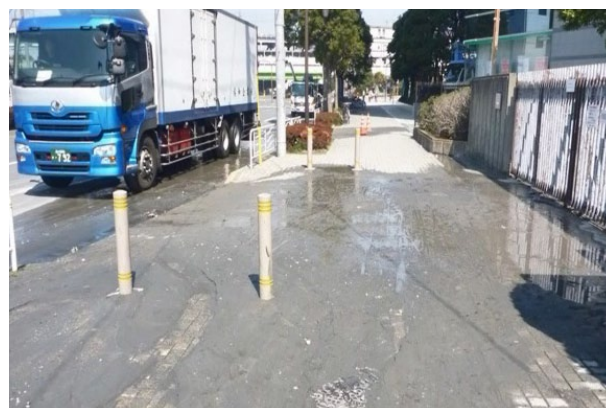
道路は液状化現象により、噴砂が発生 東京電力新木場変電所
