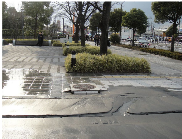
木材会館の前は「液状化現象」が起こり、マンホールが浮き上がりました。
