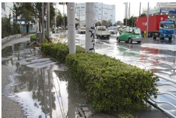
道路は液状化現象により、噴砂が発生 新木場2丁目
