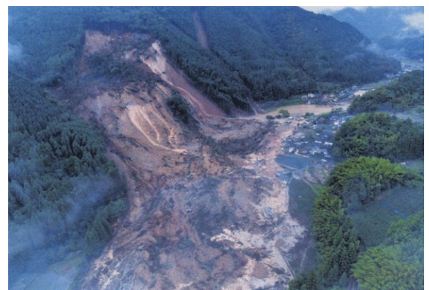
耶馬溪の土砂崩れの現場。地震もなく、水害でもなく、山崩れがあった。まだ原因は不明だが6人の尊い人命が奪われた
