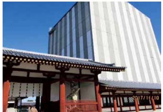
解体修理中の薬師寺東塔
