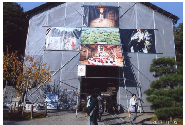
※改装中の拝殿(国の重要文化財)。今は仮拝殿が別あり、見ることも拝むことも出来ない。
