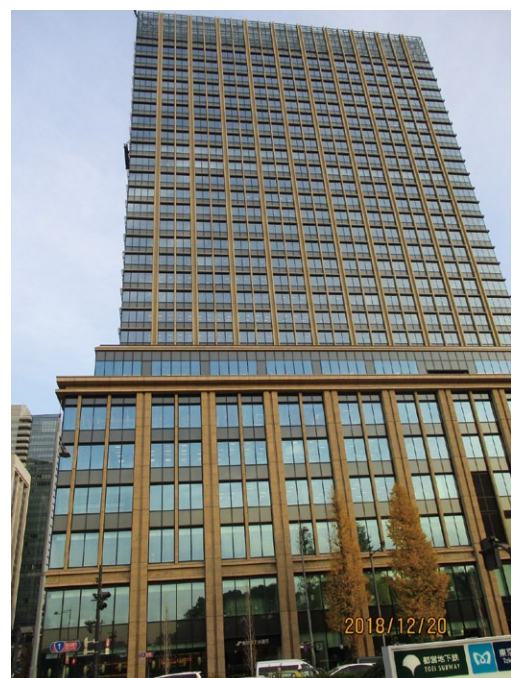
完成した東京商工会議所ビル
