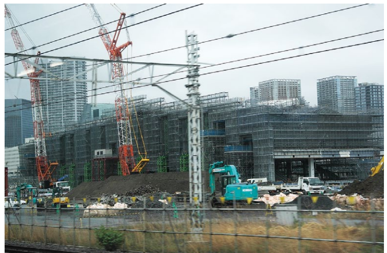
建設中の高輪ゲートウェイ駅 出典： https://ja.wikipedia.org/wiki/
