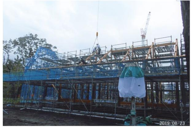
大嘗宮、トラスの組みこみ中の写真で、皮付の柱と、その他の部材の一部をお手伝いした
