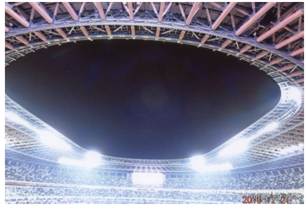
ドームの中から全体の木組を写す
