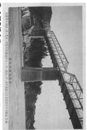
⑥-1 親鼻橋 初代 3径間 木鉄混交 上路式トラス橋
