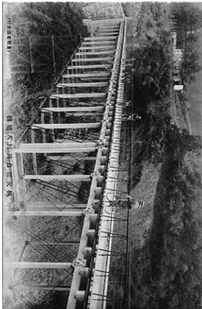
②八幡橋 3径間 木鉄混交 上路式トラス橋
