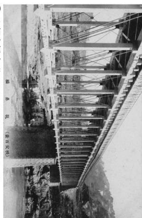
⑥-1 親鼻橋 初代 3径間 木鉄混交 上路式トラス橋
