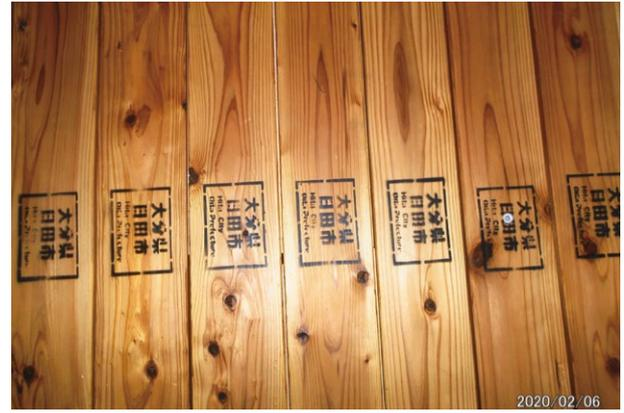
4寸角の角材で床を作っている。このように産地の焼印が全て押されている
