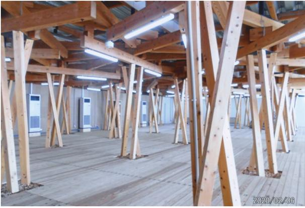
3本の角材をねじるように組み合わせて耐震性を強める構造を採用している
