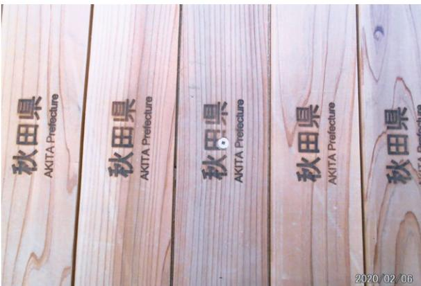
床に使われた秋田県産の角材、このように全部の木材に焼印が押されている
