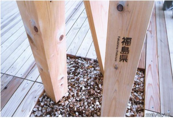
3本ツイスト左ネジレの柱で天井を支えており、下の基礎部分にチップを入れそのままの仕上りという
