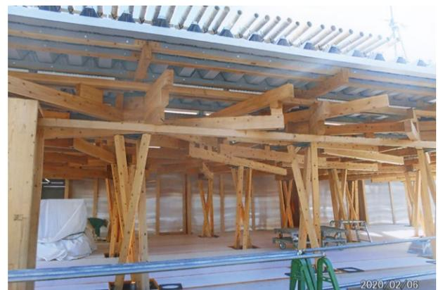
柱3本ツイスト使用、屋根には竹が施設されている
