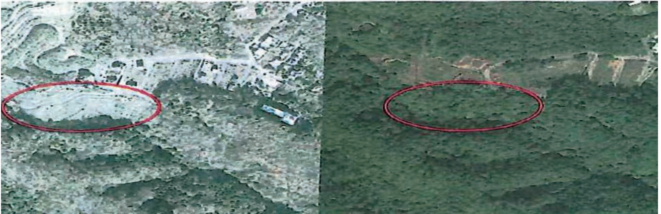
土石流崩壊現場 日本経済新聞参照
