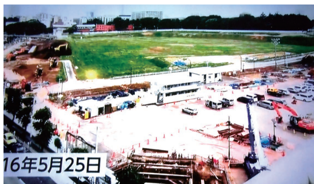
2016年、新国立競技場建設工事。始めた頃の現場風景。
