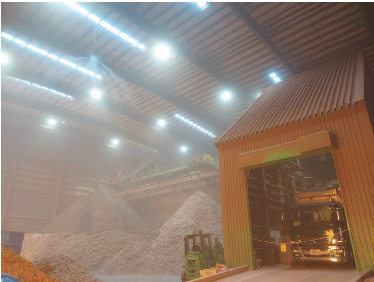
トラックダンパーの倉庫天井にはスプリンクラー、大小のチップを仕分けサイロに
