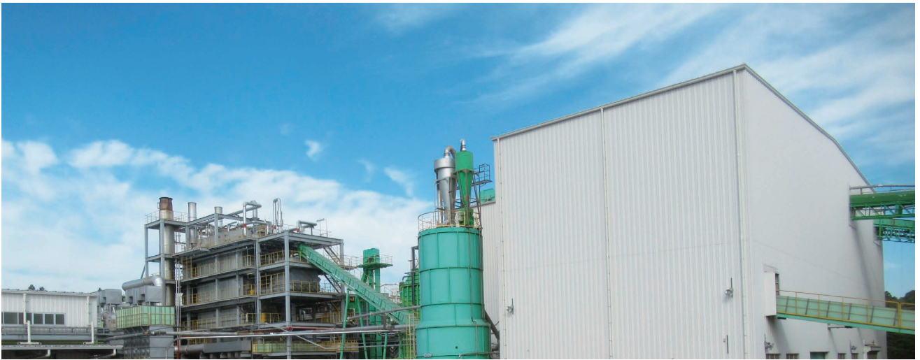
広大な敷地の中に、各工程の設備がならんでいます
