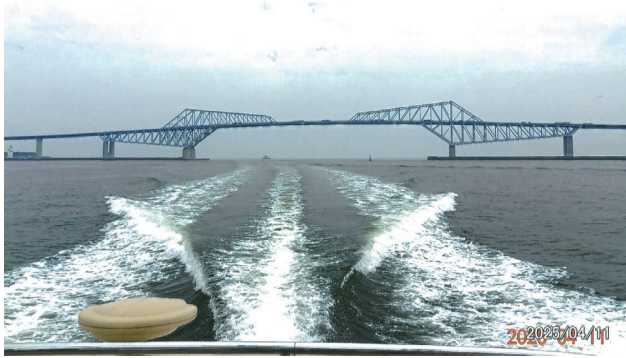
新木場近くのゲートブリッジ、船あとの水しぶき、60キロぐらいのスピードで走行中
