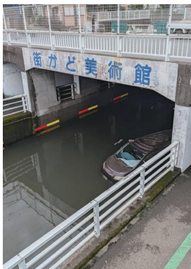
浸水したアンダーパスと 水没した車両(鎌ヶ谷市)
