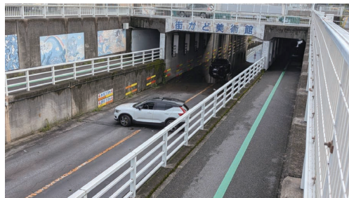
自動車が放置されたアンダーパス(鎌ヶ谷市)
